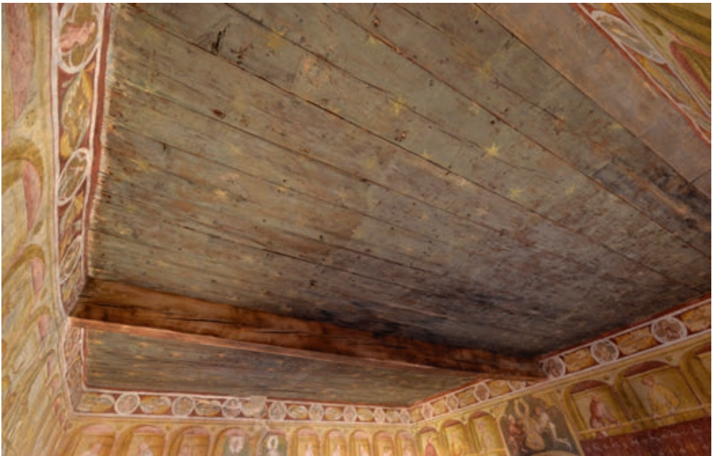
Abb. 74 Schloss Runkelstein, Westbau, 2. Obergeschoss, Kammer, Holzdecke
