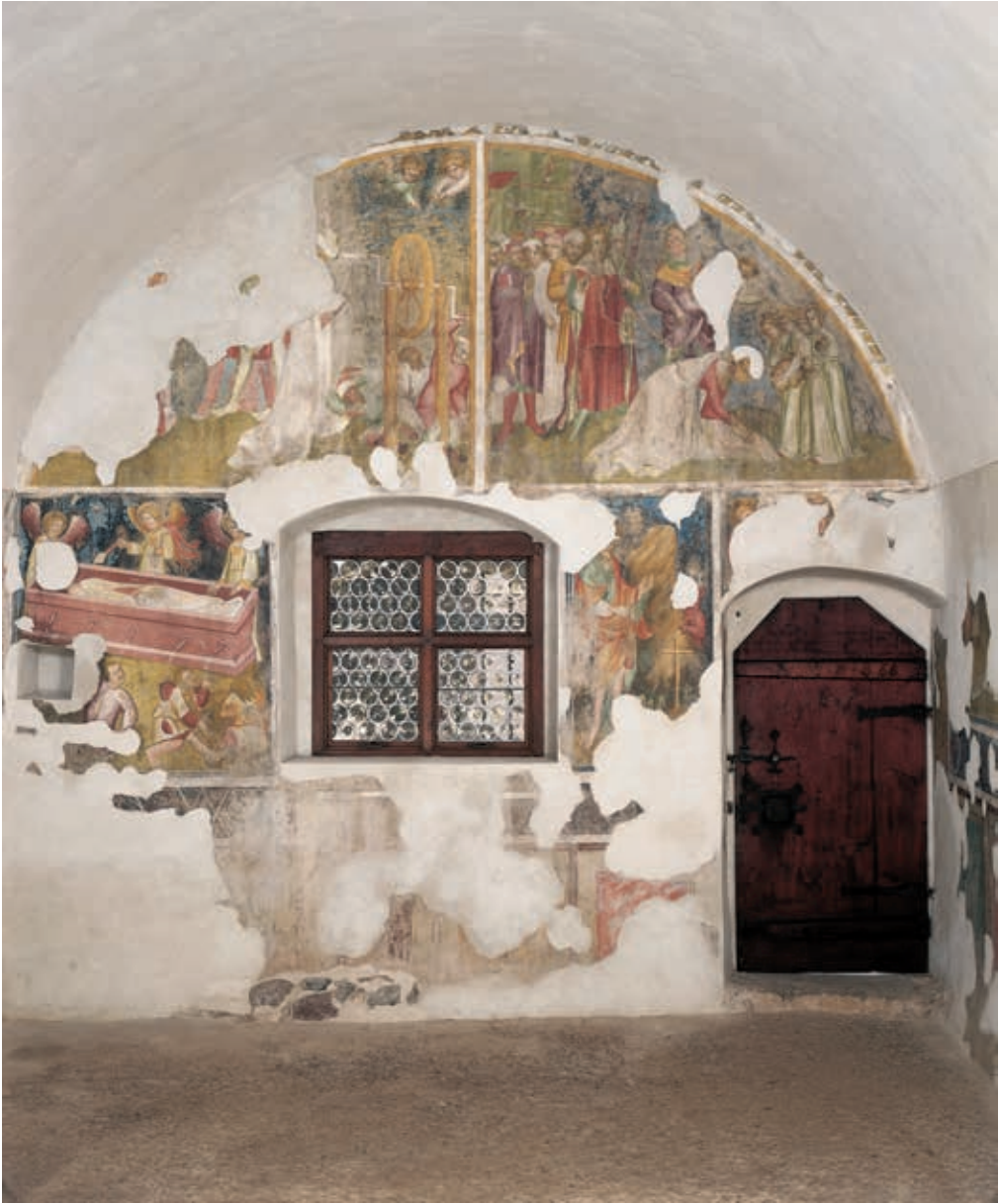
Abb. 270 Schloss Runkelstein, Kapelle, Westwand, Gesamtansicht, Zustand 1999/2000
