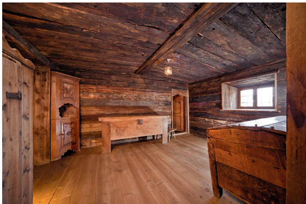
Urform der Stube, deutlich erkennbar das Satteldach über dem in Blockbau aufgezimmernten Gehäuse, datiert 1425
