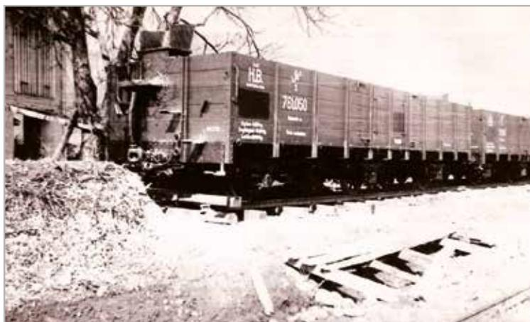
Stazione di Ora in data 20 marzo 1917: alcuni vagoni merci delle ferrovie austro-ungariche (k.u.k. HB) posteggiati sul binario morto. Dei vagoni simili per ferrovie a scartamento ridotto furono utilizzati nel trasporto del breccia dalle cave di porfido situate fra Ora e Bronzolo su una linea provvisoria fino alla stazione di Ora per preparare adeguatamente lo scalo ferroviario. Al giorno d'oggi sarebbero occorsi almeno 18.000 autotreni moderni.
