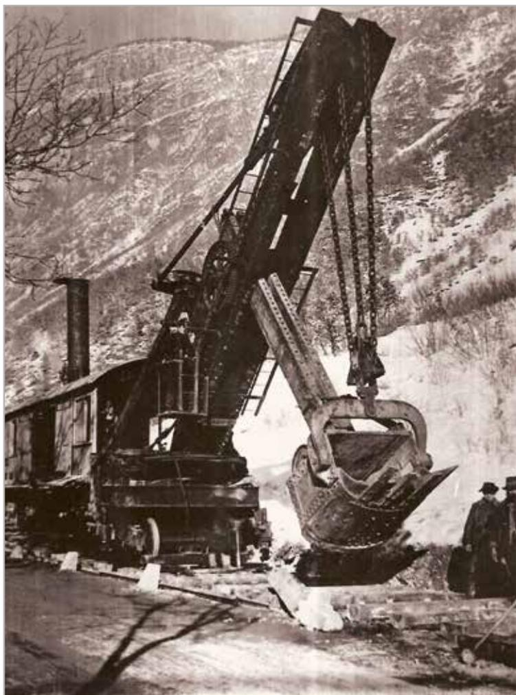
Un'escavatrice a vapore con cucchiaio (16 febbraio 1916) disposta su un binario ed utilizzata per il caricamento del pietrisco destinato alla costruzione della stazione di Ora e parte delle massicciate lungo la linea ferroviaria mentre un'altra parte del pietrisco proveniva dall'escavazione delle gallerie. Osservando le montagne sovrastanti era certamente sistemata lungo la Strada Imperiale tra Ora e Bronzolo in adiacenza delle cave di porfido.
