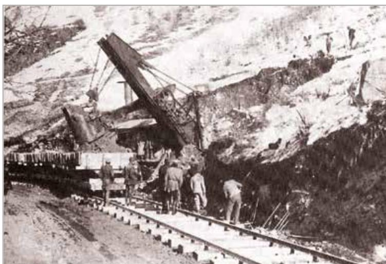
Ora 1916: l'escavatrice a vapore mentre sta caricando i vagoni merci di breccia da portare ad Ora per la costruzione dello scalo ferroviario della Val di Fiemme. Per la sua costruzione fu necessario trasportare 180.000 mc di pietrisco. Sotto i binari si notano le traversine nuove appena preparate dalle falegnamerie militari col legname abbattuto, senza alcun preavviso, nella pineta di Ora (Forchwald).
